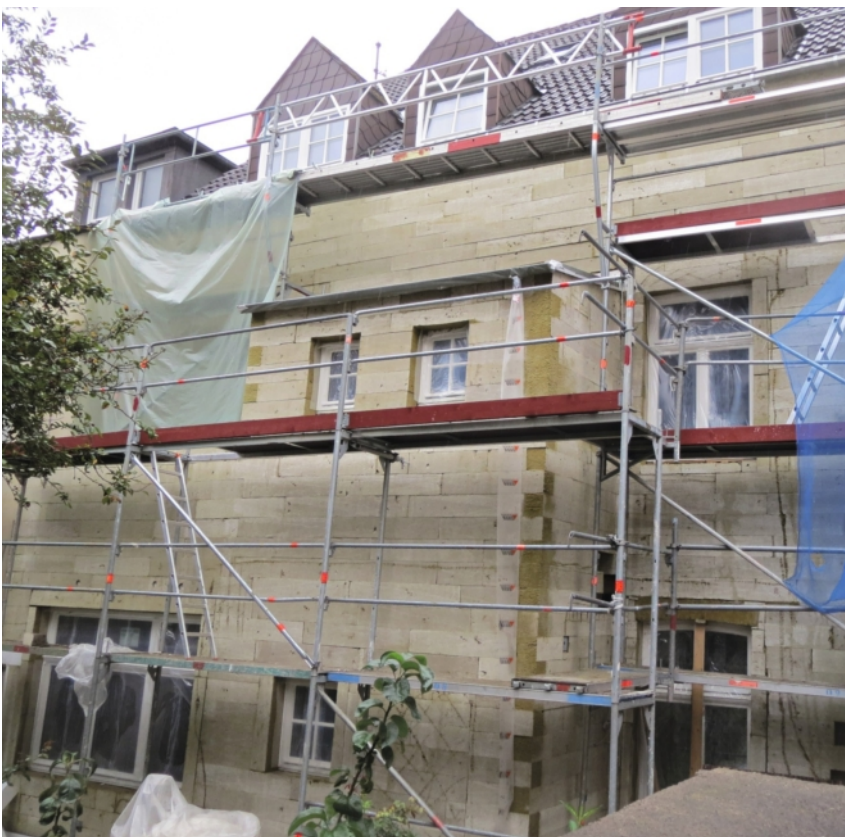
7 Als Material für die Wärmedämmung wurde Steinwolle gewählt. Sie verbesserte gleichzeitig die Schalldämmung.
